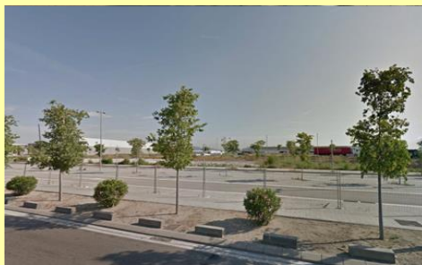
Parc industrial de PIMES
